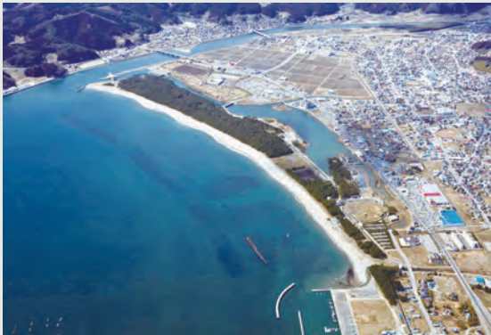
【図1】震災前の陸前高田市航空写真 (出典：いわて震災津波アーカイブ、提供者＝岩手県県土整備部河川課)
