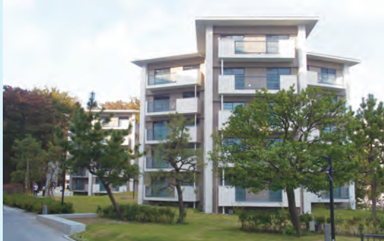
【図2】改修後の旧赤羽台団地スターハウス（筆者撮影、撮影日=2023年11月）
