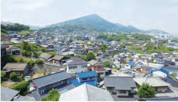
【図1】八幡東区の斜面住宅地
