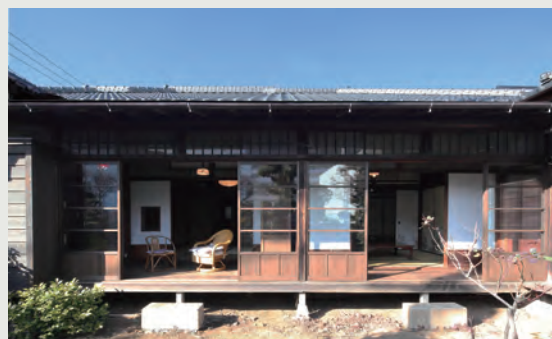
[図4] 佐々木邸南側縁側／屋根を2011年に葺き替え、建具を2012年に木製にもどした(撮影：ギャラリーエークウッド 古川泰造、2015年2月16日)
