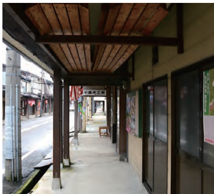
【図1】雁木の軒裏に吊される雪樋(筆者撮影)
