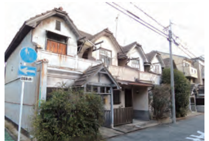
【図6】改修前の5軒長屋
