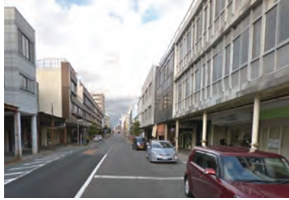
【図2】防火建築帯の事例（左写真：沼津/右写真：富士市吉原）
