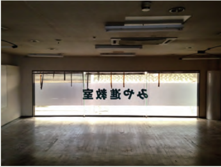
[図1] 着手前。商店街に面した大きなガラスFIX
