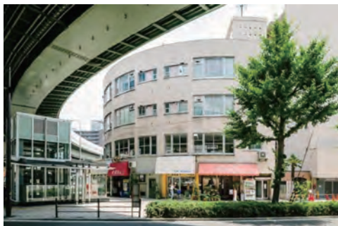
リノベーション中の新桜川住宅(アードアンドクラフト提供)
