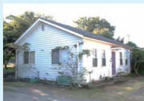
【図7】改修を終えた「米軍ハウス」
