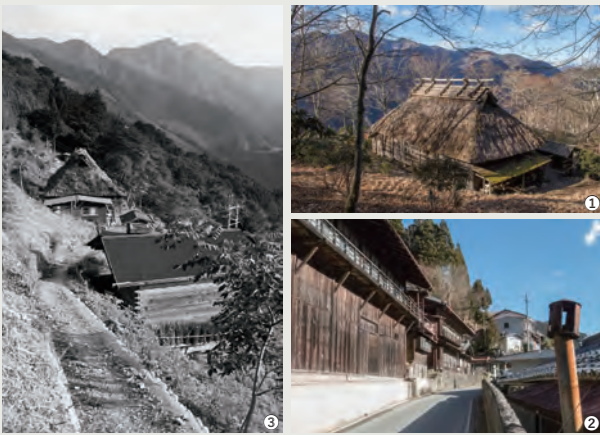
①三峯(みつみね)神社境内に移築保存されている神領民家。三峯神社南側60戸ばかりの集落の民家を移築保存したもの。入母屋造り、萱葺き屋根で、野叉首(のぎす)と呼ばれるX形の置千木(おきちぎ)が載り、なかなかの風格。建築年代は文政年間(1818～1829)と推定されるという ②栃本集落。旅籠の面影を残す民家 ③三峯集落。茅葺民家の手前に厚板造りの穀倉がみえる。いまはこうした風景は失われた [表紙] 秩父湖の左岸に沿って秩父往還道を通い、集落が点在する。右奥に栃本。セシナ機から撮影(1976年撮影) [右頁上] 荒川が刻んだV字谷の急斜面を切り拓き家々が点在する栃本集落 [右頁下] 秩父往還道をドローンで撮影。秩父往還道の秩父側再奥の栃本集落には、50数戸の民家が点在していた。山越えの要所として武田信玄によって設けられたのが栃本関所の始まり。白泰山を越えて信州へ、雁坂峠を越えて甲州へと結ぶ街道だった。いまも、栃本関所跡には江戸時代に建てられた関所役宅が残る(国指定史跡)
