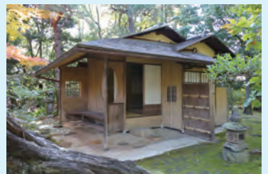
〔写真10〕袴付及び待合/入母屋造、こけら葺きの軽妙な建物。大きな円窓が穿たれ、庭の風景と流れの音を室内に取り込む(筆者撮影)
