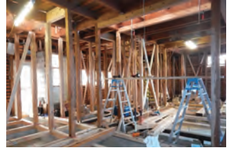
[写真2] 泉北スタイルの家1号の改修中
