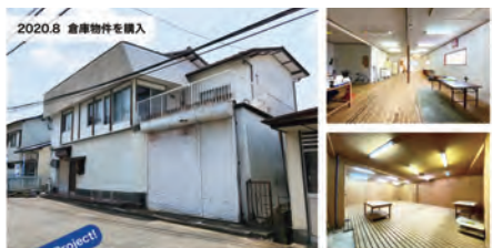
【図9】3階建木造倉庫を樋井川アートセンターとして開設予定
