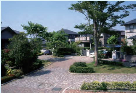
〔図2〕青葉台ぼんえらふ(1993年、福岡県北九州市106戸) 近隣の家でコモンを囲むクラスターを構成し、それらを曲線の集散道路が繋ぐクラスターコモンの造成計画
