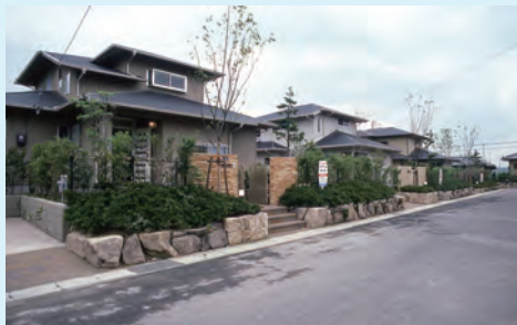
〔図1〕可児桜ヶ丘ハイムHOPE住宅(1984年、岐阜県可児市66戸) 恵那石、美濃焼タイル、ソイルセメントなど地域の材料で作った外構設計
