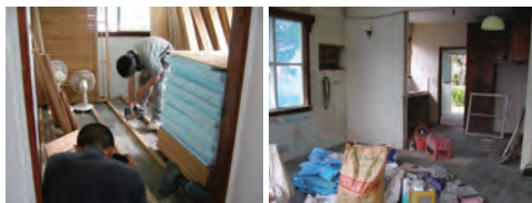
【図2】入居当初の様子。住みながら、DIY施工で内装を仕上げた
