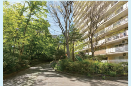
〔写真6〕住棟と植栽管理の関係
