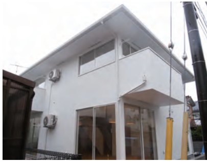
【図1】ペアレンティングホーム合掌苑外観 (東京都町田市金森東/2016年7月開設)
