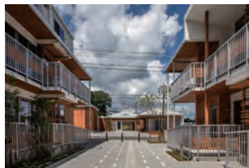
〔図2〕木質の景観、連続するパブリックスペースをもつ災害公営住宅とコミュニティ施設(撮影:浅川敏)
