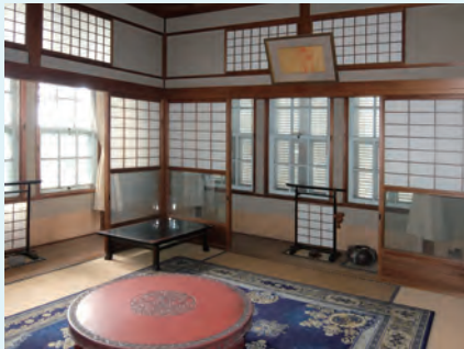
上:〔図2〕 外観(現在) 下:〔図3〕 2階座敷/周囲に縁側が設けられ、和室意匠が外からは分からないように配慮されている
