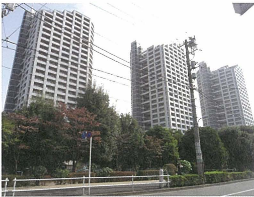
写真3 対象となった都心超高層マンション
