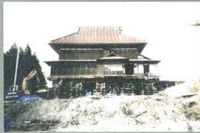
⑤ジャッキアップ
