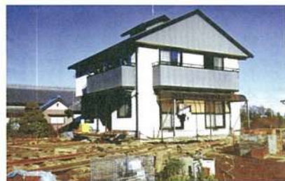
図1 区画整理に伴う住宅の曳家。近年のハウスメーカーの住宅はベタ基礎のものや、土台がないものが多い。そういった住宅は基礎共の移動工法で曳家される。(写真提供=日本曳家協会)
