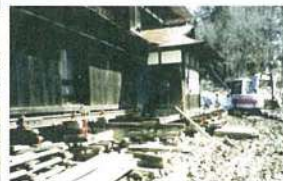
②補強鋼材腰付作業
