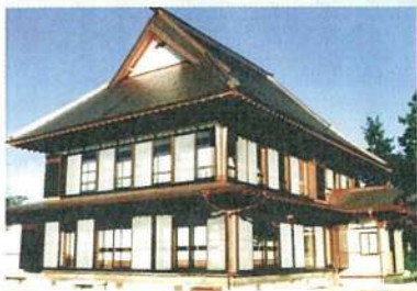
⑥基礎へ納め、改造工事
