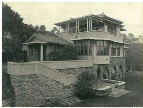
写真2 外観竣工当時（写真=清水建設株式会社所蔵）
