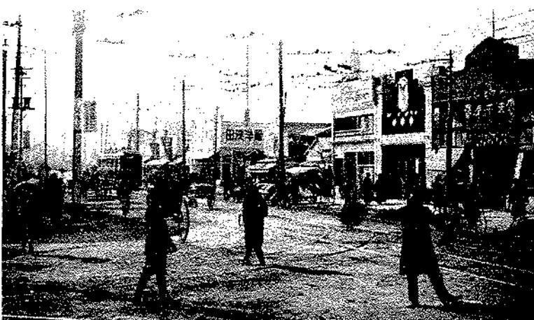
図5(右)、図6(左) 神田区小川町付近における区画整理前(右)と後(左)の街並み。区画整理の前後でバラックの階数や立面が大きく変貌した様子がわかる。この沿道は甲種防火地区(最低限、外壁を耐火構造とする義務があった)に指定されていたため、写真にみられる木造モルタル塗建築は、いずれもバラックである。
