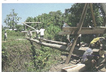
図-13 移住者が力を合わせて橋や道をつくっている
