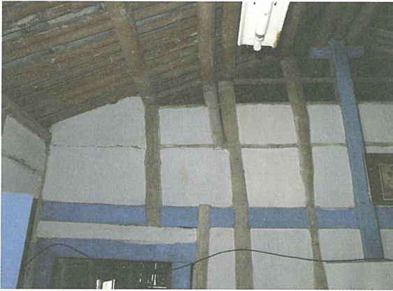
図-4 材の一部を木材に置換した竹造家屋 (台南県左鎮、2008年筆者撮影)
