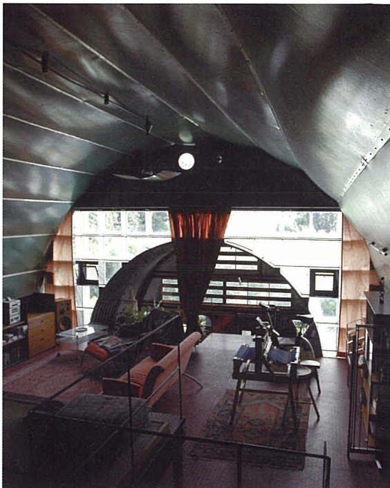
厚さ2.7mmのコルゲート鉄板でできた真木邸の外観と内部。竣工は1996年。左は真木ご夫妻。
