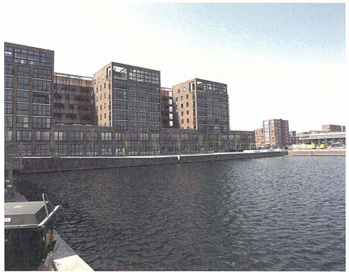
将来のコンバージョンを予測して、階高やスラブ厚は大きめにつくられ、ファサードの構成もフレキシブルに設計される。構造・構法システムはシンプルだが、供寸法・使用は長期使用を前提にして、すこぶる頑丈だ。オランダのエネルギー供給は、ある時期から集中体制を排して分散化とともに、エネルギー源多様化を目指してきた。風力や太陽光発電への依存も徐々に進む。
