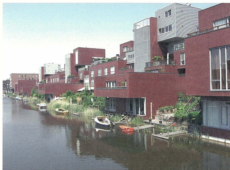
オランダは建設ブームで、アムステルダムにあちこちでも住宅建設が進行中。集合住宅は、「低層高密度」がこの国の原則だが、そこにもさまざまな「ロバスト化」のアイデアが見える。さまざまな所得階層の人びとの混住を前提にする住空間の構成もまた、「ロバスト化」をめざす住宅政策・計画のうえでの方針だ。実に多様な内外空間の構成が見られる。プライバシーを確保するためにもごつい壁壁・界床が必要になる。
