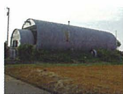
厚さ2.7mmのコルゲート鉄板でできた真木邸の外観と内部。竣工は1996年。左は真木ご夫妻。
