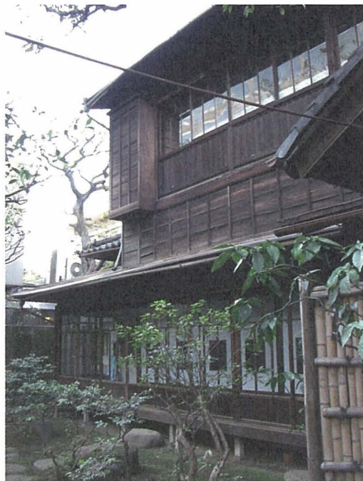
写真一 市田邸 南側の庭に面する主屋の縁側。
