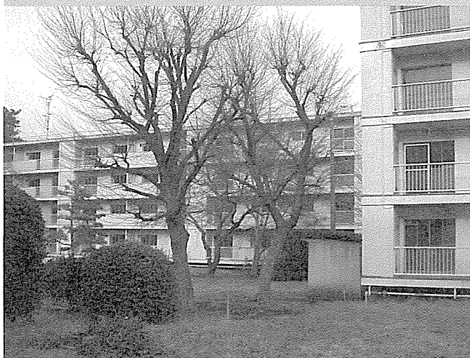
写真—1 建て替え前のアートヒル高根台敷地。
