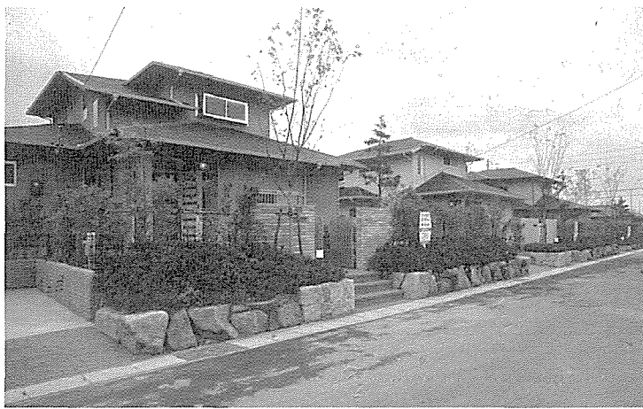
写真一 桜が丘ハイツHOPE住宅祭（岐阜県可児市） 統一外構による街並み景観整備の例。恵那石積み、美濃焼タイル、乾式レンガなど、外構部材は地域のものでつくられている。
