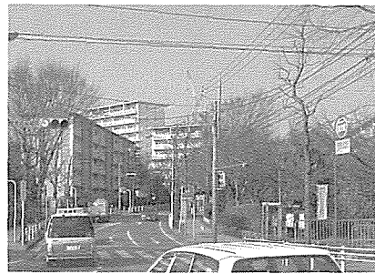
写真—2 建て替えられ高層になったアートヒル高根台8・9号棟遠景。
