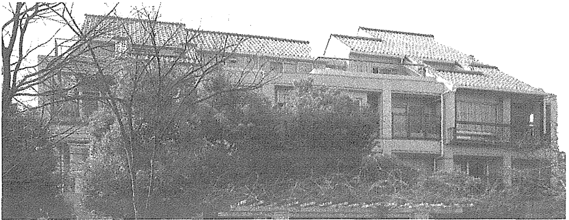
北側の公園からみたロジコート 10年目の大規模修繕では、外壁の色も階段のアクセントカラーの黄色やブルーも忠実に再現された。次の機会にはイメージチェンジするのもいいかもしれない。
