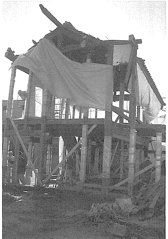
写真—21 解体の様子(側面)。多くの通し柱で構成されているのがわかる。
