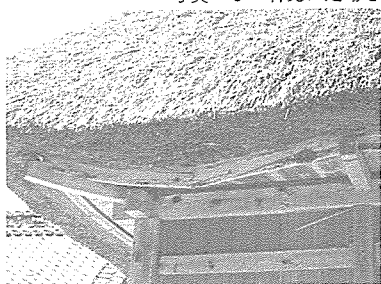
写真一九 折れて下がった軒先の様子。
