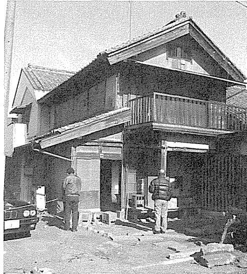
写真一16 移築中の町屋。正面四畳半、奥行き二間半の町屋。
