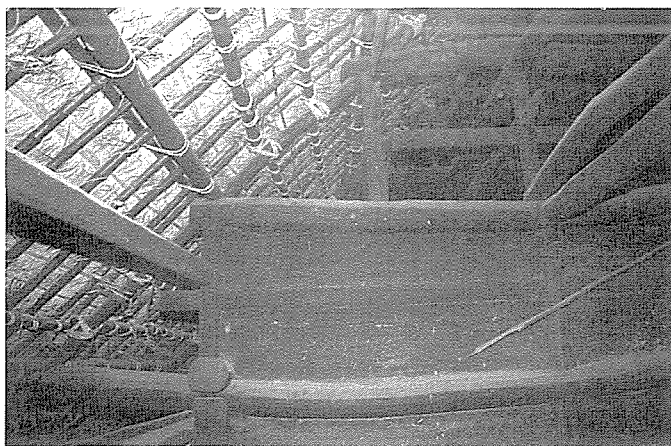
民家のクモ壁とその小鬘（この隙間をくぐる）。
