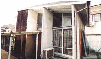
現在の東側外観。* 母屋とつなぐ屋根つき通路がつくられている。
