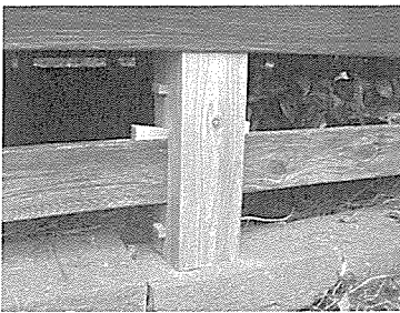
写真一5 修理完了。
