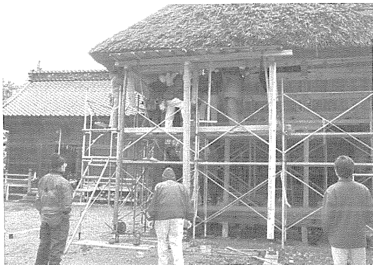
写真一六 軒先に足場を組んでジャッキで上げて修理。
