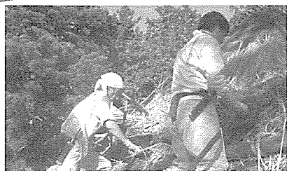
写真—14 茅葺きの修理の様子。
