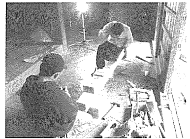
写真一3 傷んだ束を外して加工。
