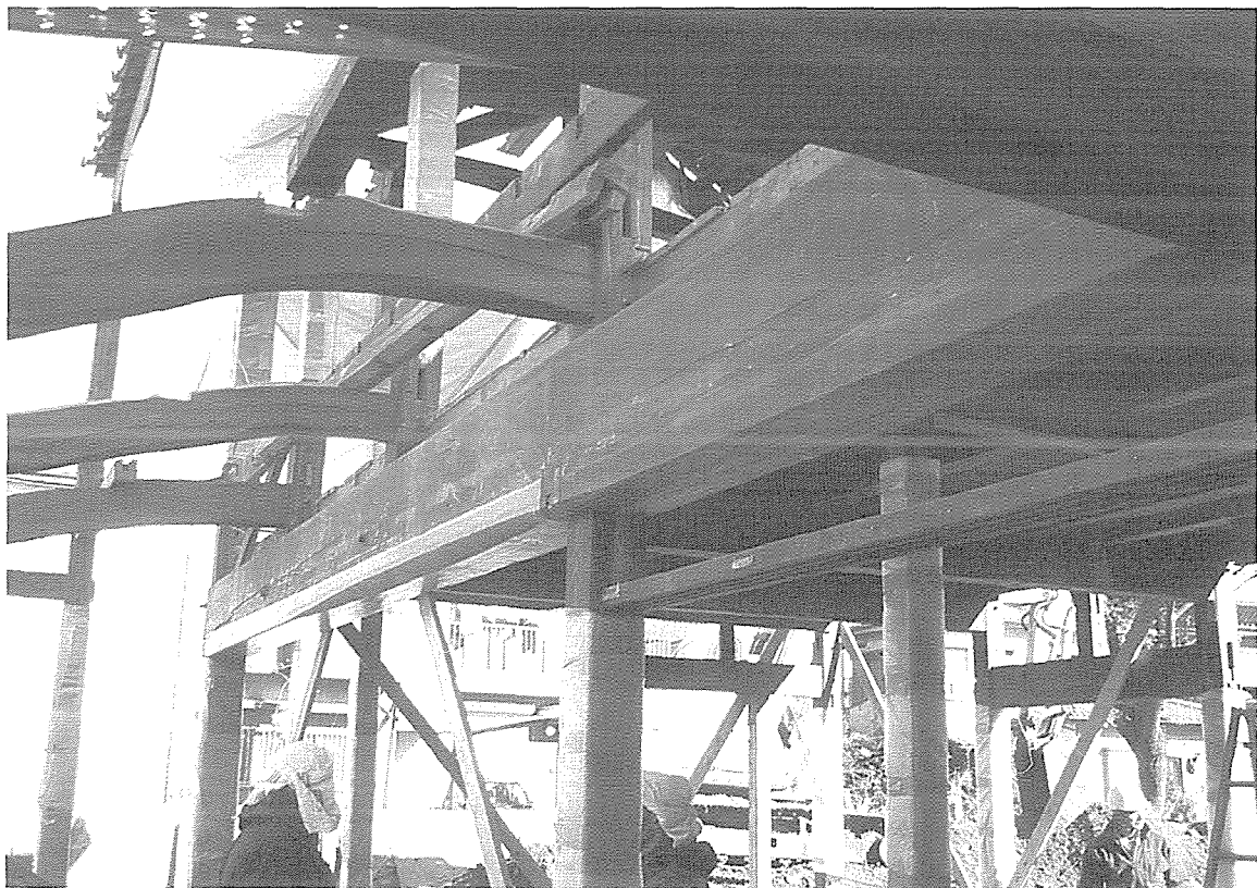
写真—20 解体の様子（正面）。商家の正面を飾る櫓の胴差。
