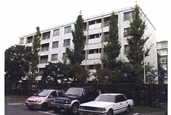
SM工法による3号棟。
