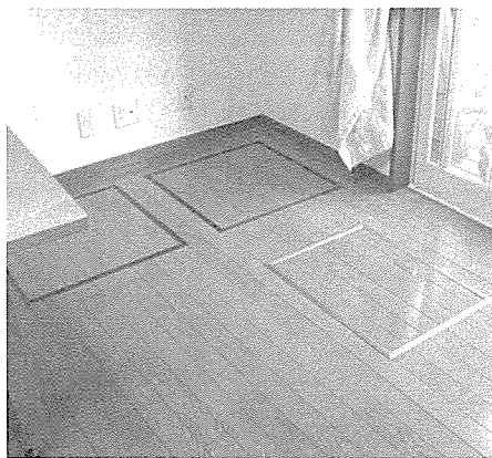
写真—5、6 リビングの床には、AV機器等を収納している。そのため、表面には何も存在しない。AV収納は、電動で上下する。使用時、テーブルの入れ換え時など、必要に応じて上げて使用する。
