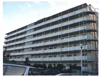
鉄骨造のフレームが特徴的な1号棟。
