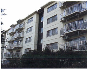
居住空間が外側に配置されるセンターコアシステムによる6号棟。
