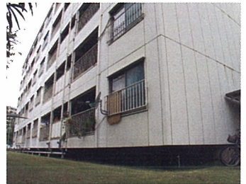
ブロック工法により注目を集めた5号棟。
