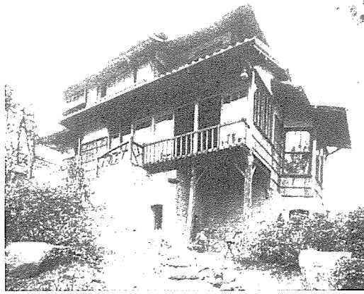
竣工頃の南面外観。（日高家蔵）
