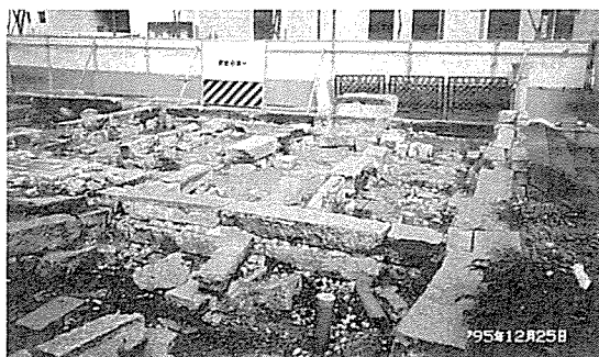
倒壊したガレキを除いて現れた基礎石の状況。
