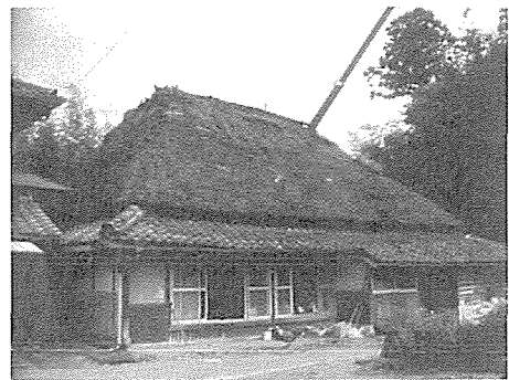
トタンを外して茅葺きの姿に戻した外観。
