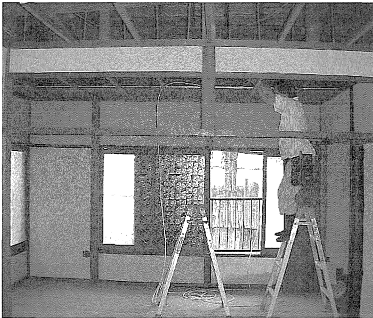
写真一八 築80数年の長屋を改修する大工。
