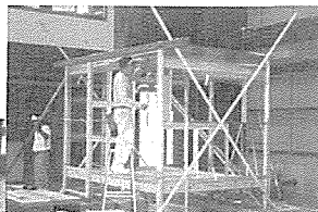
「待庵」そのままの構法で組み上げる。
