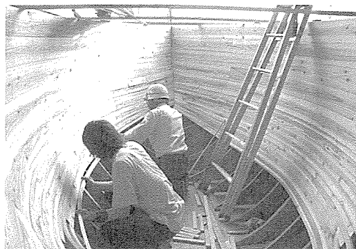
写真一 2 コンクリート舟の作業（杉型枠）。
