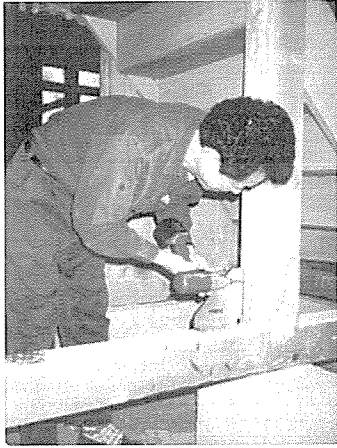
図一5 伝統構法住宅の改築事例
