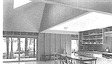
8.2mスパンのワンルーム。複合梁が垂れ壁の効果を生んでいる。
