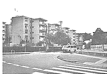
写真-19 千里ニュータウン、初期の公営住宅に一部屋増築を行なったもの。
