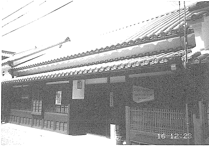
17世紀の町家を改修した 今井まちづくりセンターの外観
