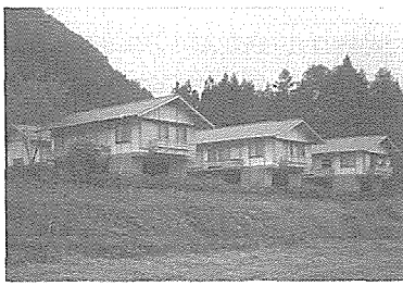
⑭金山型住宅のモデルとしての町営住宅
