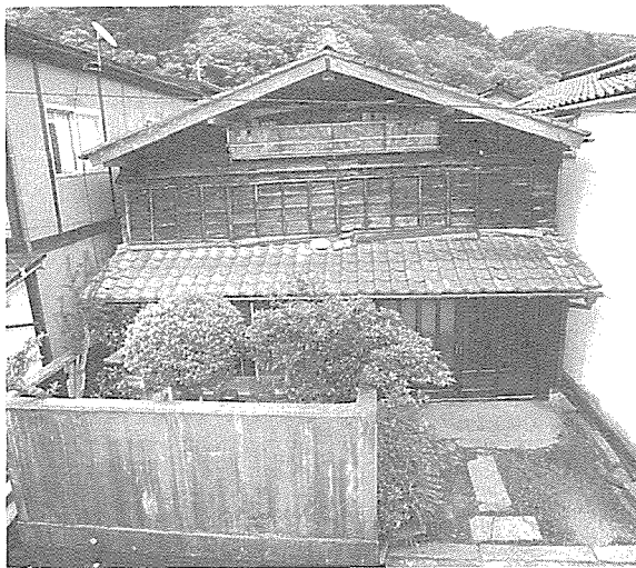
石名坂家・仲町小路に面する修理前の外観
