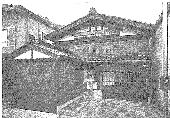
石名坂家・修理後の外観
