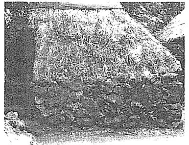
ところで、住居の主屋が変化しても、隠居屋とか雪隠(便所)、屋形(小屋)、牛舎などの付属舎には古い構造が残されています(図-3)。雪隠と牛舎は坂上地区と坂下地区で構造が異なり、「八丈実記」には「雪隠トハ……坂下ハ高ク石ヲタ、ミ上ニ屋根ヲ葺坂上ハ平地ニ桶ヲ埋メテ、屋根ハ同シ」、「牛屋ヲ既ト呼ヘリ。坂下ハ三方石垣、坂上ハ丸木ノ掘立ナリ。イツレモ屋根ハ地筋葺ナリ」とみえます。「又八坪七分五厘、又七坪半ハ隠宅」とあり、隠居屋は一間取りの住まいが多かったようです。さらに、屋形と称する小屋のことは、「丸木皮ナガラノ掘立柱、四壁ハ石垣或ハ茅ニテオ、ヒ、土間ニ篠竹ヲ並べ、筵シキタル土生小屋也」とあって、ホンダテ導入以前の住居とよく似た記載がなされているのです。
