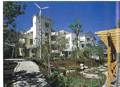
ビオトープを抱いた集合住宅。安定した生態系を保全、再生し、住まいの自然な健康・快適さを目指した。 写真／内木政治
