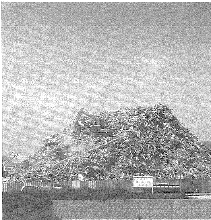
写真-1 阪神淡路大震災後、伊丹市に出現した住宅解体廃棄物の山 (1995年6月2日撮影、伊丹市役所提供)
