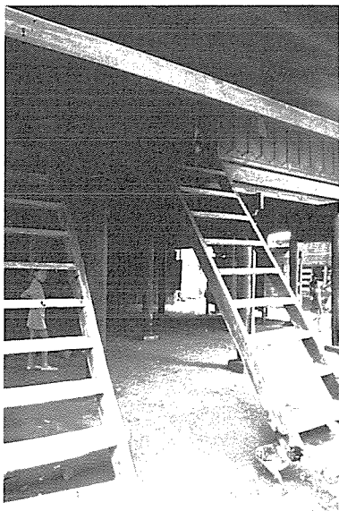
高床の住居の床下を見る。
