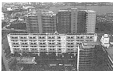
再開発の進む中、解体直前の全景。1997年夏。
