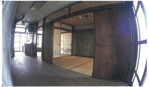
解体前の非廊下階の住戸。
