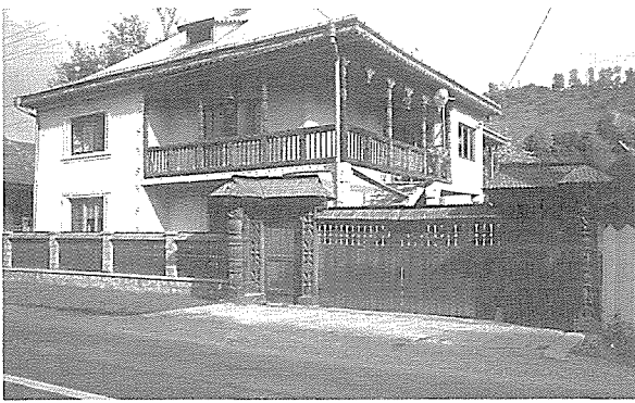
移動中に見つけた民家。門には「1988年」と、つくられた年代が彫られている。この地域の伝統が装飾という形で、新しい住宅と融合している。
