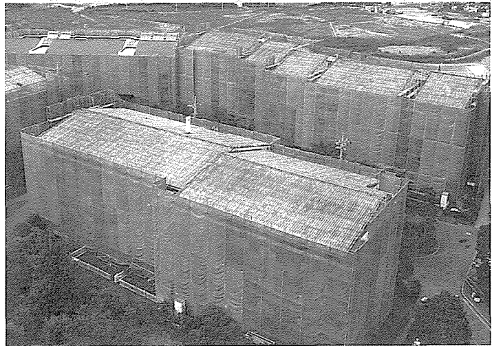
大規模修繕工事中のマンション。(46~51頁写真/岩為)
