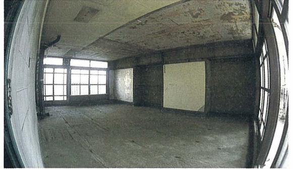
内部造作を取り払った状態。
