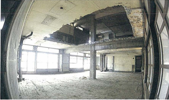
上階との一体化—スラブ抜きした状態。
