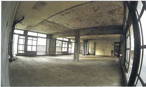
戸境を取り払い出現する2戸分のスペース。
