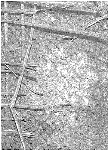
写真—5 旧岡本自邸における鉄網コンクリート施工の実際
