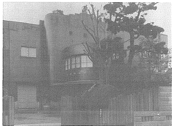
写真13 朝倉彫塑館におけるコールタール塗りの外観
