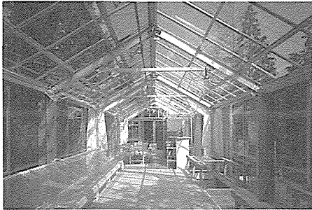
写真：2階温室部分
