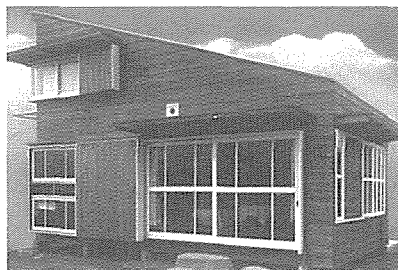
池邊陽「立体最小限住居」1950年 新建築9512臨時増刊「現代建築の軌跡」より転載 写真／平山忠治
