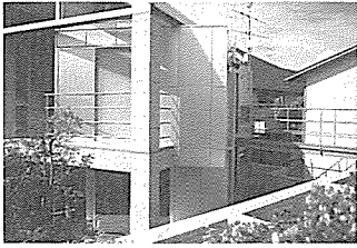
写真-2.15 ブリッジで屋上テラスをつなぐ
