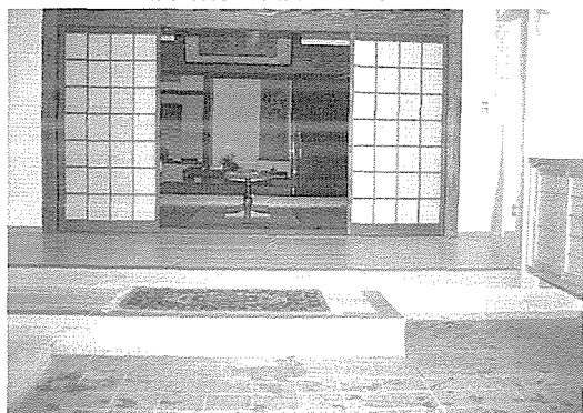
写真-5 一部がテーブルリフター（下降状態）の玄関式台。正面奥は和室対面所。
