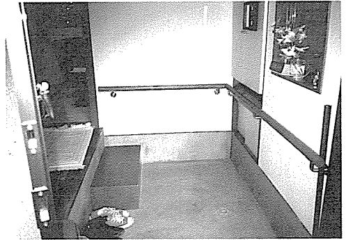
写真-1 40センチぐらい段差がある玄関に、ステップをつくって手すりをつけた例。立位歩行ができる場合、このぐらいで対応できることが多い。
