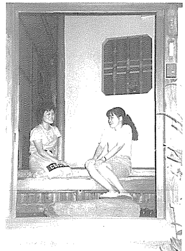
図一23 現代住宅の玄関 現代住宅の玄関でも、ひと昔前までは沓脱ぎ石があり、また、玄関の土間からユカ上へ上がるところには立派な材を用いて上がり框が設けられた。この一線を越えて「玄関へ上がる」ことが重要であった。玄関には家人が坐っており、客は上がりはなにも腰掛けて応対する場面も多かった。この玄関の段差は45センチ。*
