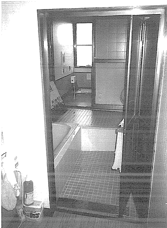
写真12 車いすから乗り移っていざって移行するのと、またいで入るのと、両方入れるようにお風呂を改造をした例。
