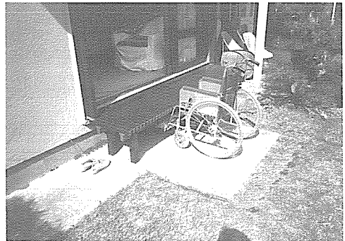
写真一五 緑側のテラスを使って車いすからそのまま移行する例。脳性麻痺で、いざり移動なら自分で移動ができる方の場合。
