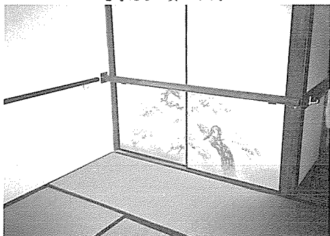
写真一八 中棚の高さに木をわたして手すりをつけた例。引き戸ならば、こういう方法で軽い障害には対応できる。
