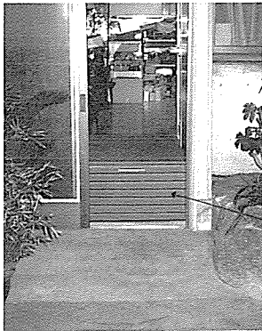
写真-4 段差解消機を組み込んで、スロープ化を図らなかった例。
