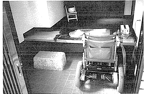
写真-3 住宅改造で、あえて40センチ近い段差をそのまま残した例。車いすの座面から、そのままストレートにいざり移動で床面に降りる。他の方は一段ステップを使って上がり降りする。
