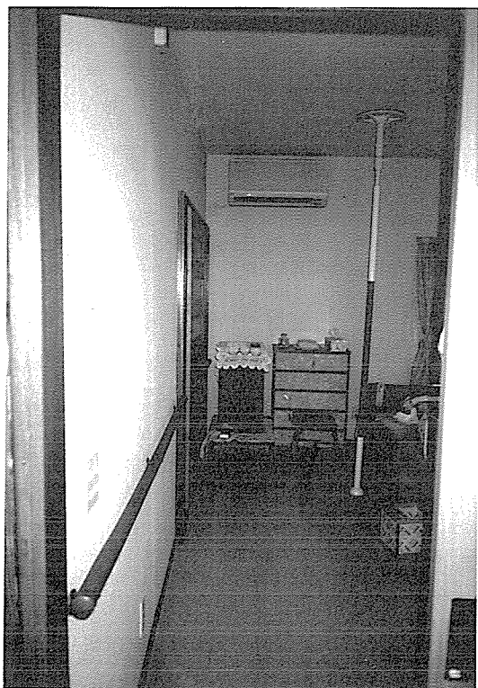
写真一九 室内の壁まで手が届かないところで布団から寝起きするために、特殊な手すりを付けた例。
