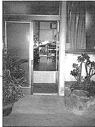
写真-2 新築住宅で、段差をなくした例。腰掛けて上下足の履き換えをする。
