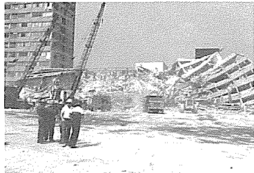
写真一 4 メキシコ地震による団地倒壊。
