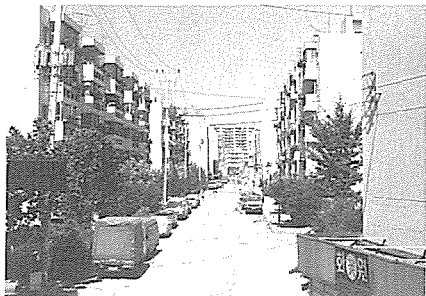
写真一４：公営住宅（1970年代初めに建設）
