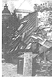
写真一 3 関東地震による倒壊家屋。
