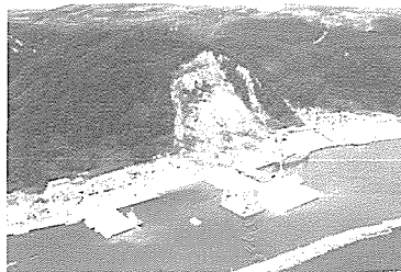
写真一 日本海中部沖地震による山崩れ。
