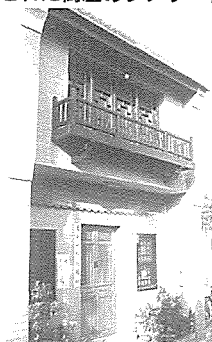
写真一2 鹿港鎮：修景された街屋のファサード
