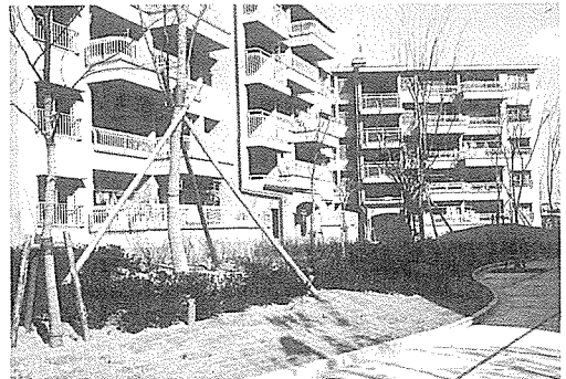
写真1 二段階供給の実際例—泉北桃山台 (大阪府住宅供給公社)
