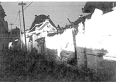
写真一 2 インドネシア、ラセムの白壁の街並み
