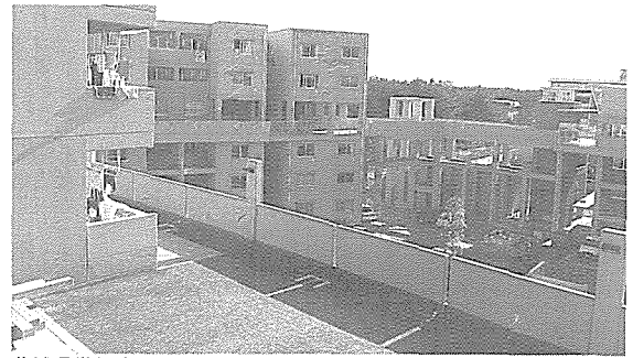
茨城県営松代アパート 設計=大野秀敏+三上建築事務所・アール総合計画事務所 中層住宅の中間階に第2の地面（「上の道」）を設定する試み。
