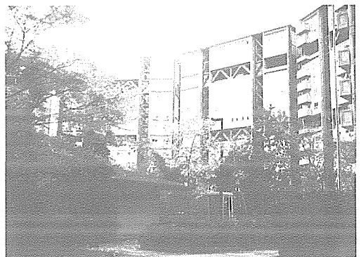
芦屋浜の高層住棟
