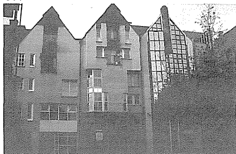
写真-P 中世の敷地に建つ新建築 (フランクフルト)
