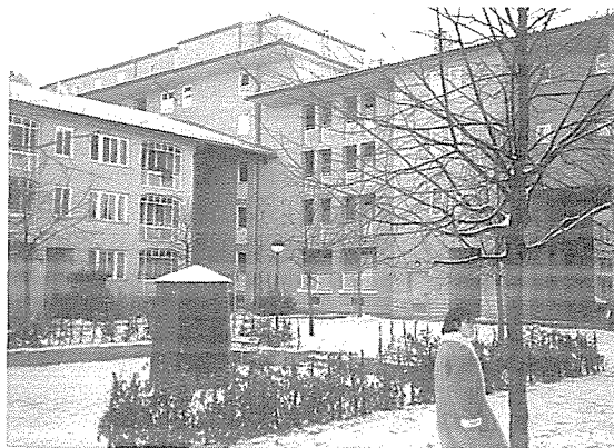
ミュンヘン・ヴェストエンド街区の中庭 右側に見える2層吹抜けのゲートが周辺住民の通り抜けルートになっている。
