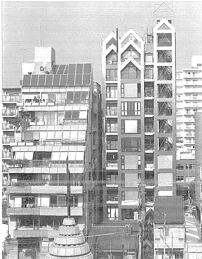
都住創13号スパイヤー(右)と10号釣鐘町(左)の南面
