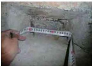
図9 水平接合部はつり調査
