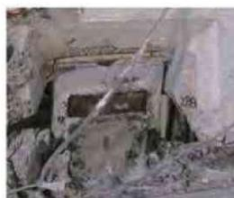
図 18 SB 隅肉溶接破断
