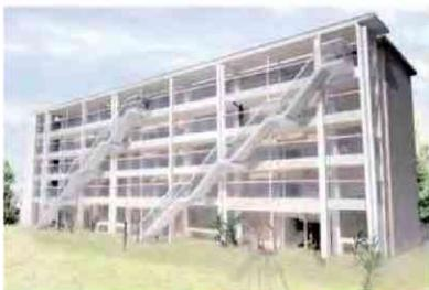
図5 WPC構造集合住宅の改修／ELV設置、新設壁開口、新設床開口などにより、ストックを有効利用できる可能性は高い
