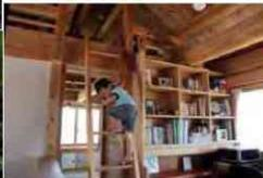
左：四寸角のスキ材を使い一寸の厚板を落とし込んでつくる地元の大工棟梁による建築
