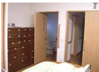
写真 7 押入れをなくし、トイレの介助スペースに変えた。左はトイレへの出入口、右は居間への出入口
