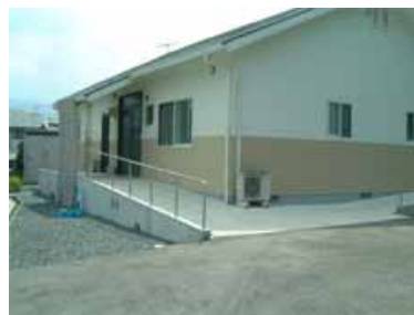
玄関～スロープ
