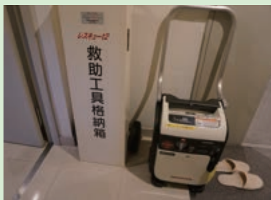
E: 救助工具・発電機
