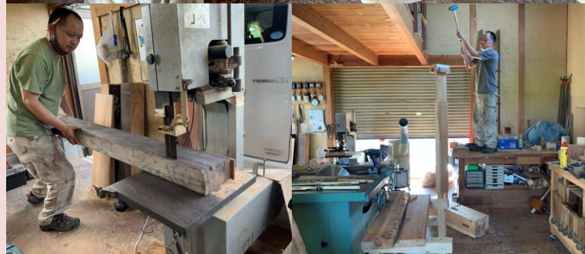
図7-5 古材を前柱に加工し、土台-前柱の仮組(2021.8.1~19)
