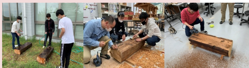
図7-2 土台洗浄(2021.4.23)~釘抜・カンナ掛け(2021.5.13)
