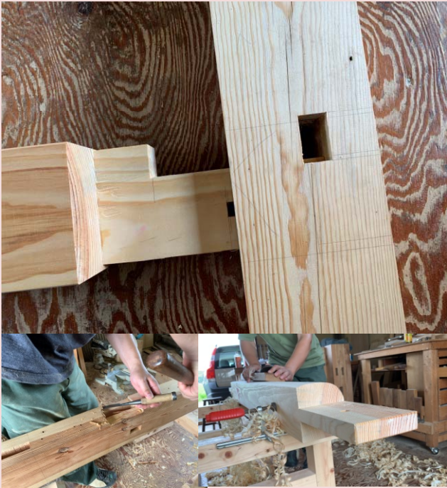
図7-6 前下張-前柱の取り合いと後下張り(2021.8.26)
