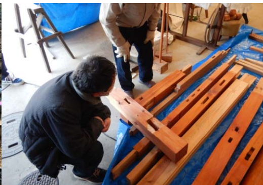
図3-4 土台加工,加工済み部材の確認と仮組(2021.3.22)
