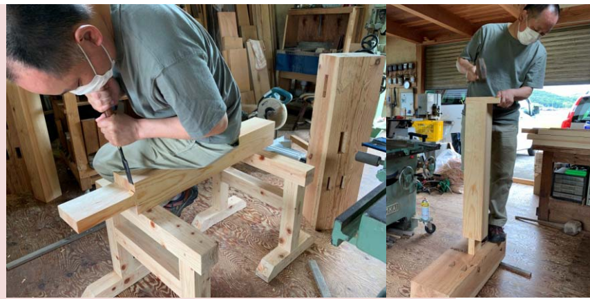
図7-4 後柱加工と仮組(2021.7.18)
