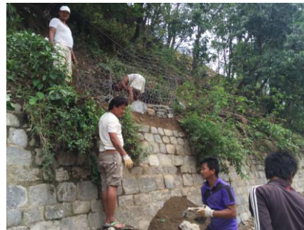
蛇籠施工風景
