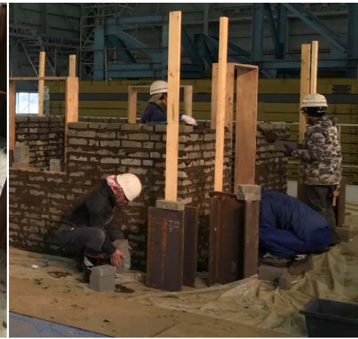
組積壁の施工
