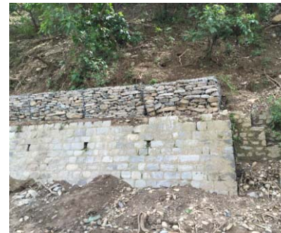
蛇籠による斜面補強
