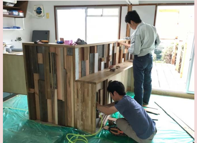
図3-1 104号室カウンターDIY作業（2016年6月）
