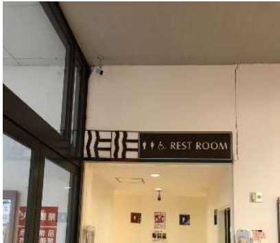
写真 2-1 開口部角からのボードのひび割れの例 (2021年の福島県沖を震源とする地震、商業施設)
