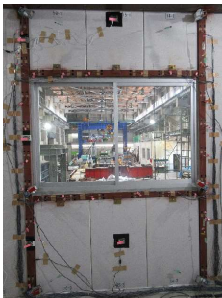
写真 4-8 引き違い窓を下地側から見た様子
