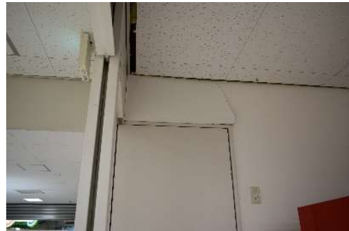
写真 2-2 開口部角からのボードのひび割れの例 (2021年の福島県沖を震源とする地震、商業施設)
