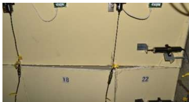
写真 5-6 上張りボードの面外方向への傾斜 (表 5-9 中(8)) (セット 7 の層間変形角-1/50rad 時)
